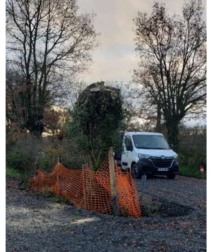
Arbre taillé en têtard sur le chantier
