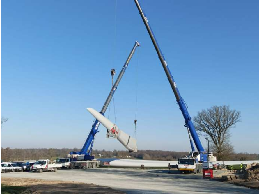
Double levage des pales
