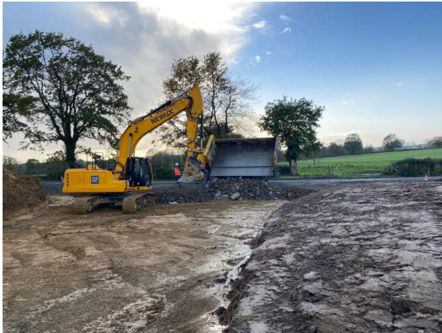
Route d'accès en cours de construction
