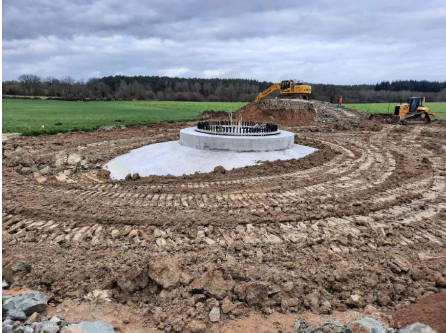
Remblayage des fondations
