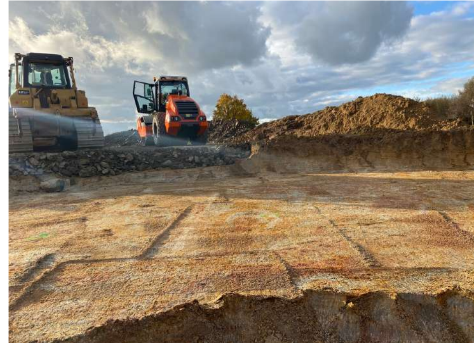
Plateformes en cours de construction
