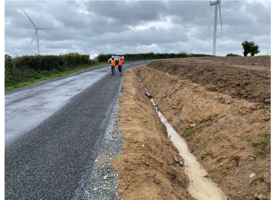
Elargissement de la chaussée et curage des fossés au bénéfice de la commune
