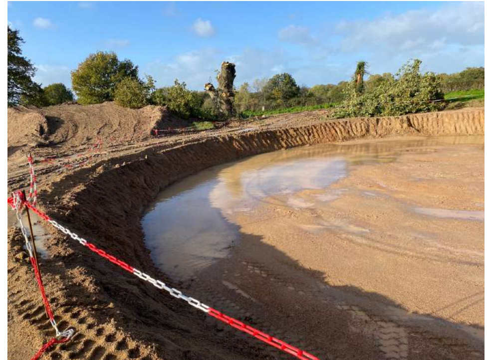
Préparation des fouilles (arène granitique)
