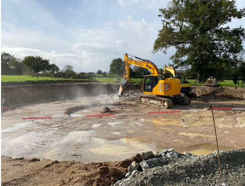
Préparation des fouilles (veine de granite altéré)
