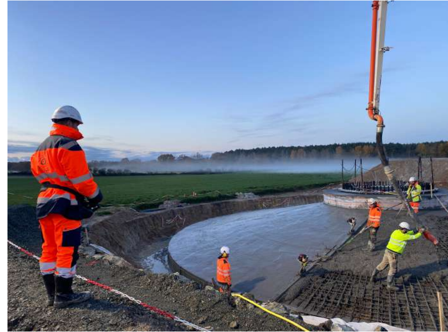
Bétonnage des fondations
