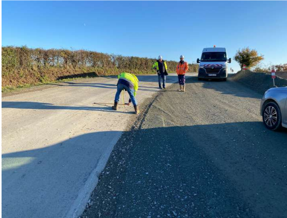
Contrôle de la chaussée
