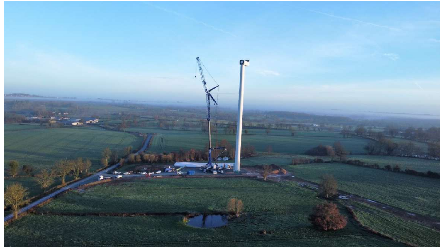
Montage du mat avant l'installation des pales
