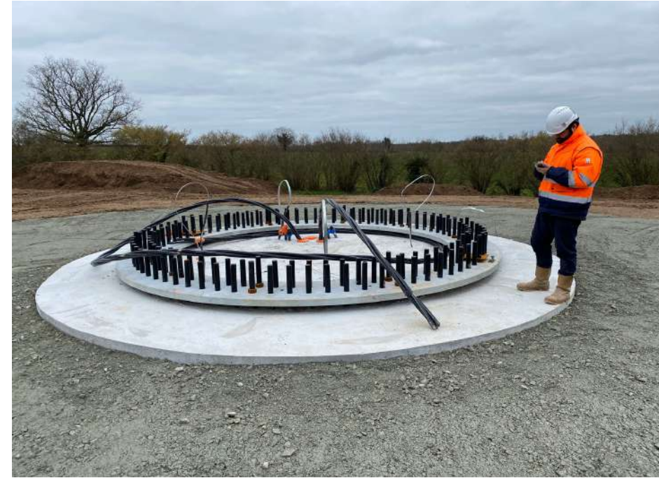
Contrôle des fondations
