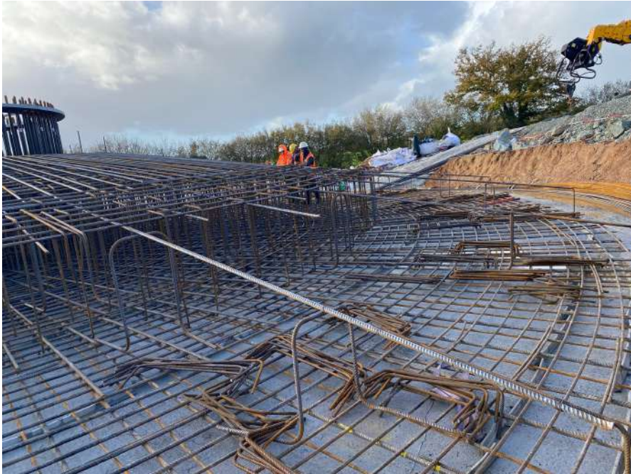
Ferrailage des fondations
