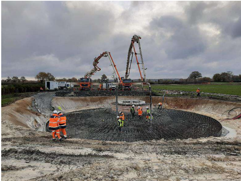
Un coulage continu avec échantillonnage du béton à chaque toupie.
