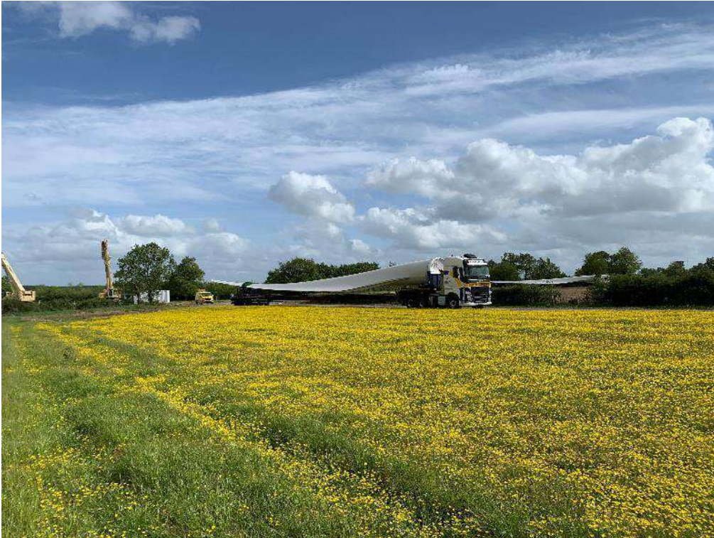
Les pales de plus de 50 m de longueur arrivent sur site.
