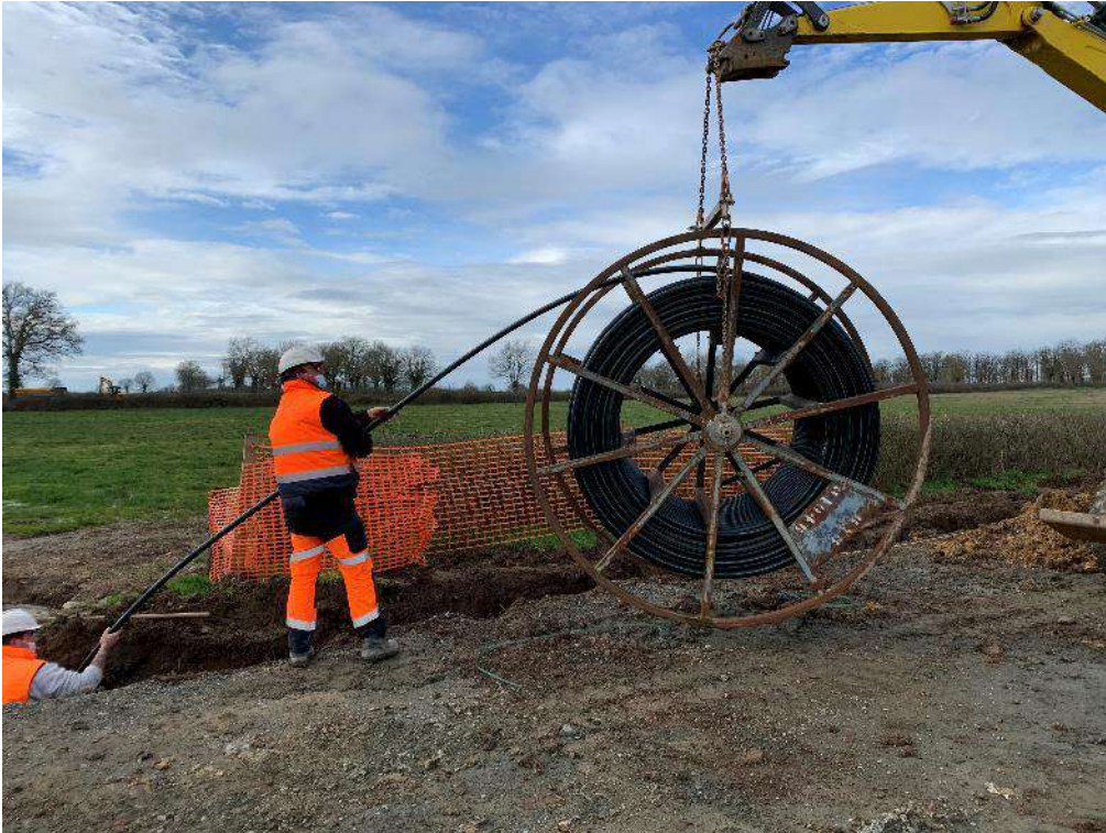
Câblage inter-éolienne pour les relier ensemble jusqu'au poste de livraison.
