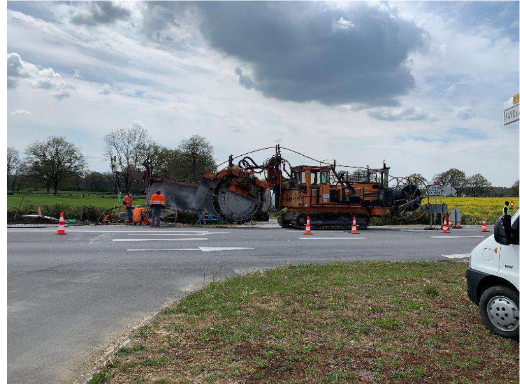
Pose du câble jusqu'au poste source permettant l'injection de l'électricité sur le réseau de distribution.
