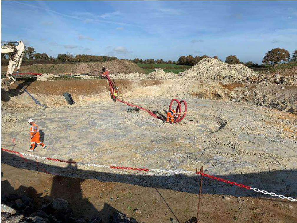
Excavation et passage des fourreaux
