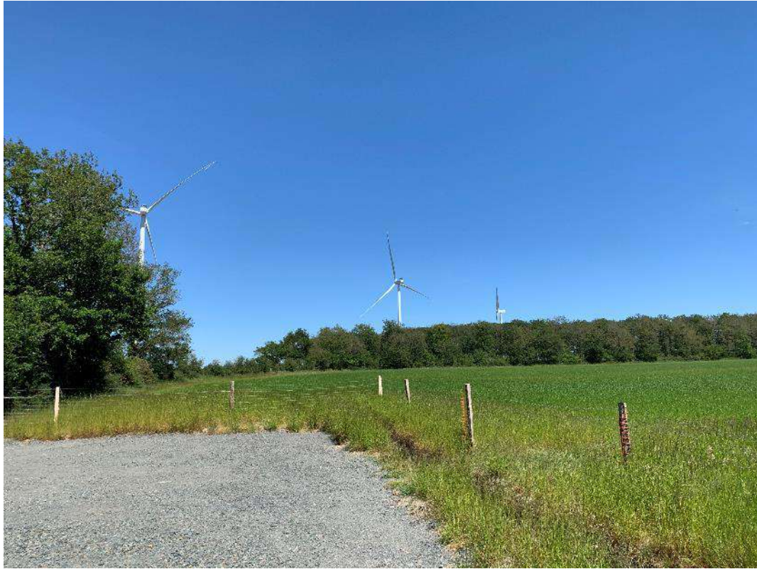
Les trois éoliennes sont montées.
