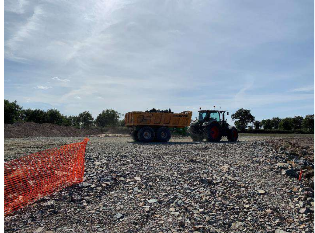
Plateforme de grutage empierrée
