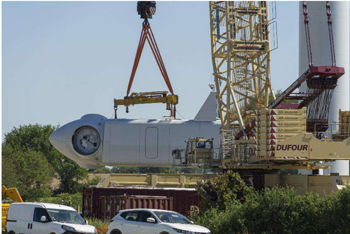
Levage du rotor et de la nacelle jusqu'au sommet de la tour.
