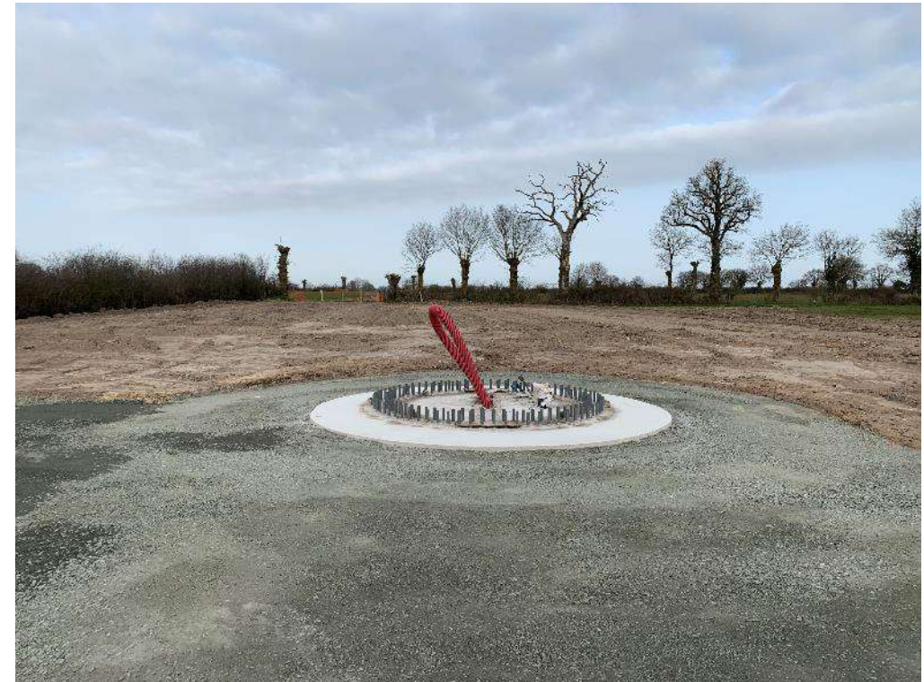
Un temps de séchage respecté avec tests de résistance sur les éprouvettes prélevées.
